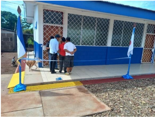
新校舎の一部
